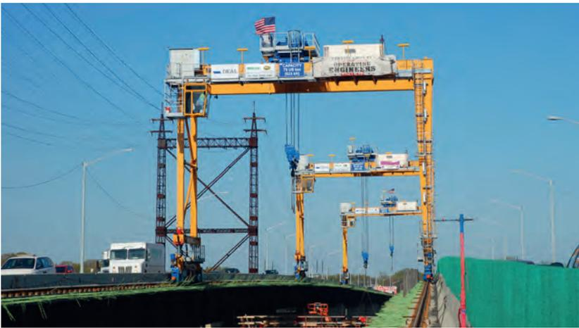
Una grúa pórtico especial, con el nombre código 'G19', ha sido diseñada por Deal para la reconstrucción del Puente Moses Wheeler que une Stratford y Milford en Connecticut, EE.UU.
