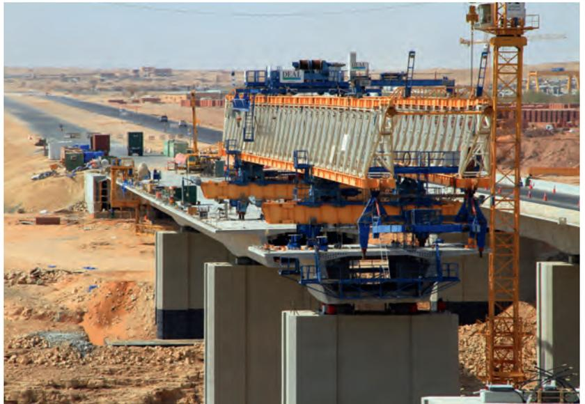
La fabricación de los elementos prefabricados pudo iniciarse apenas cuatro meses después de la adjudicación del contrato, gracias al trabajo realizado durante la etapa de 'reingeniería' para preparar y enviar al sitio todos los equipos de prefabricación especialmente modificados.
