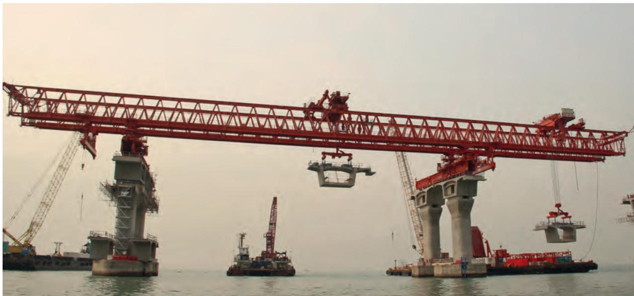
**El 'Dragón Rojo' ha vuelto a la construcción de puentes después de años de inactividad. Una distintiva viga de lanzamiento se está utilizando para construir viaductos prefabricados como parte de un proyecto importante del puente y del túnel que conectará las ciudades de Hong Kong, Zhuhai y Macao en el Delta del Río de las Perlas**
