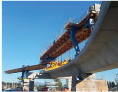
La característica 'con bisagras' del equipo permitió que se usara una sola armadura para toda la sección de la línea elevada, con poca disrupción del tráfico local y de las comunidades.
