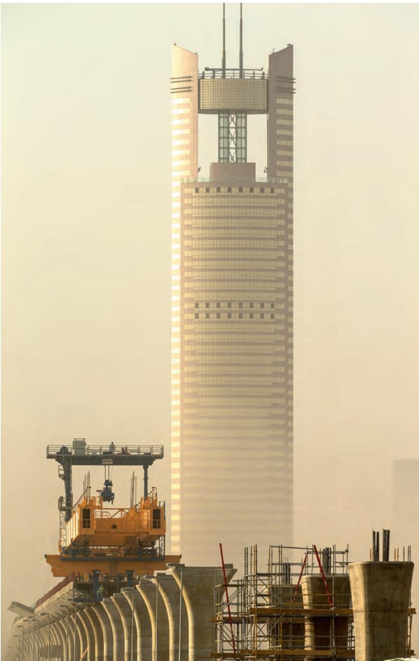
**El método vano a vano se está utilizando para lograr altas tasas de erección en la construcción de las secciones elevadas de dos líneas de metro**
